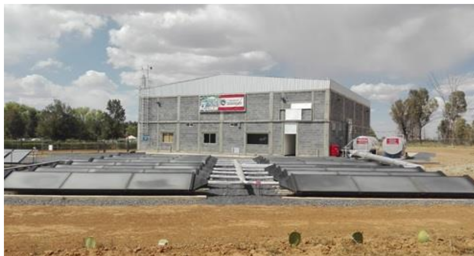
Figura 1. Vista general de la planta de secado híbrida termosolar-gas LP Zacatecas.
