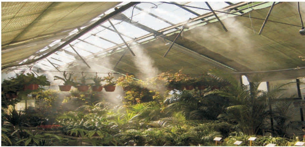
Fig. 1 Riego por aspersión en un invernadero, la secuencia se puede controlar, por medio de un PLC (controlador de lógica programable) que permite la optimización del uso de la misma.
