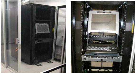
Figura 3. Vistas parciales del nodo computacional de bioinformática, donde se aprecia la infraestructura de soporte del lado izquierdo y del lado derecho una toma más a detalle del servidor principal y su consola.
